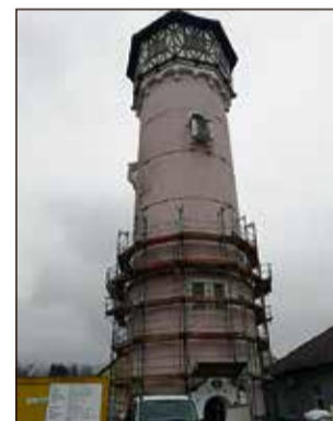
Pogled na stolp med obnovo
